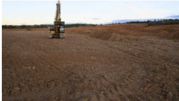
Exemple de phase d'ouverture des tranchées en cours de réalisation avec une pelle de 20 t
