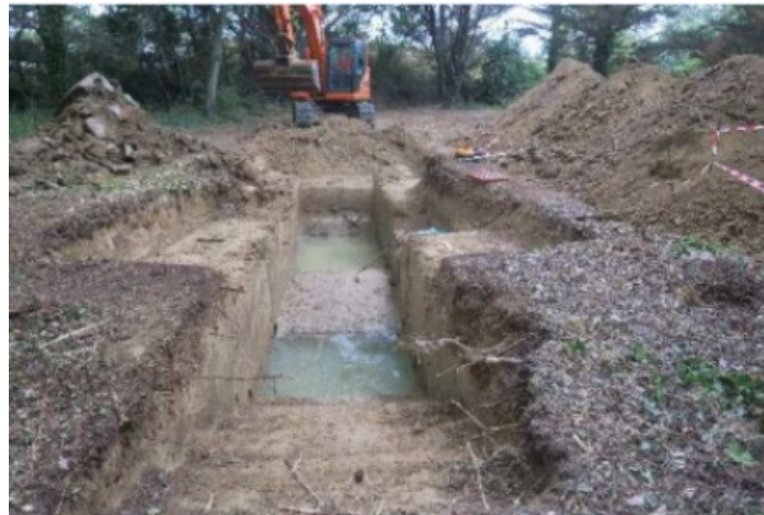
Exemple de tranchée nécessitant de réaliser des paliers
