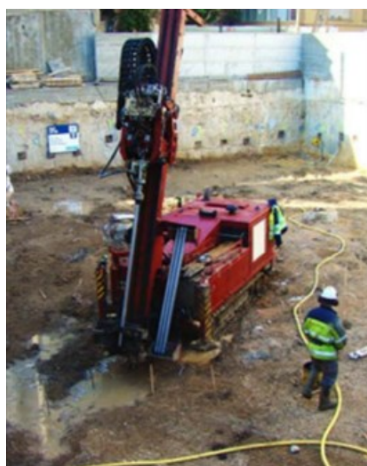
Exemple de forage destructif
