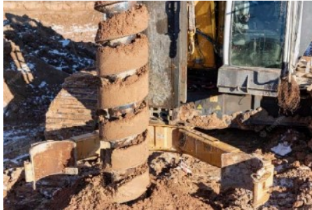
Extraction d'échantillon remanié à la tarière
