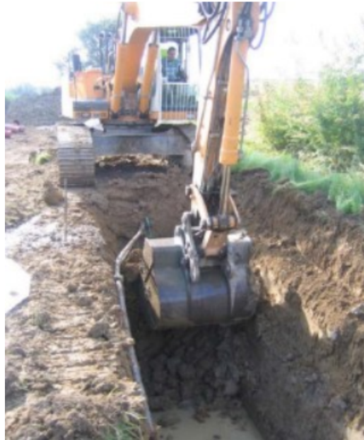
Réalisation d'un puits à la pelle mécanique
