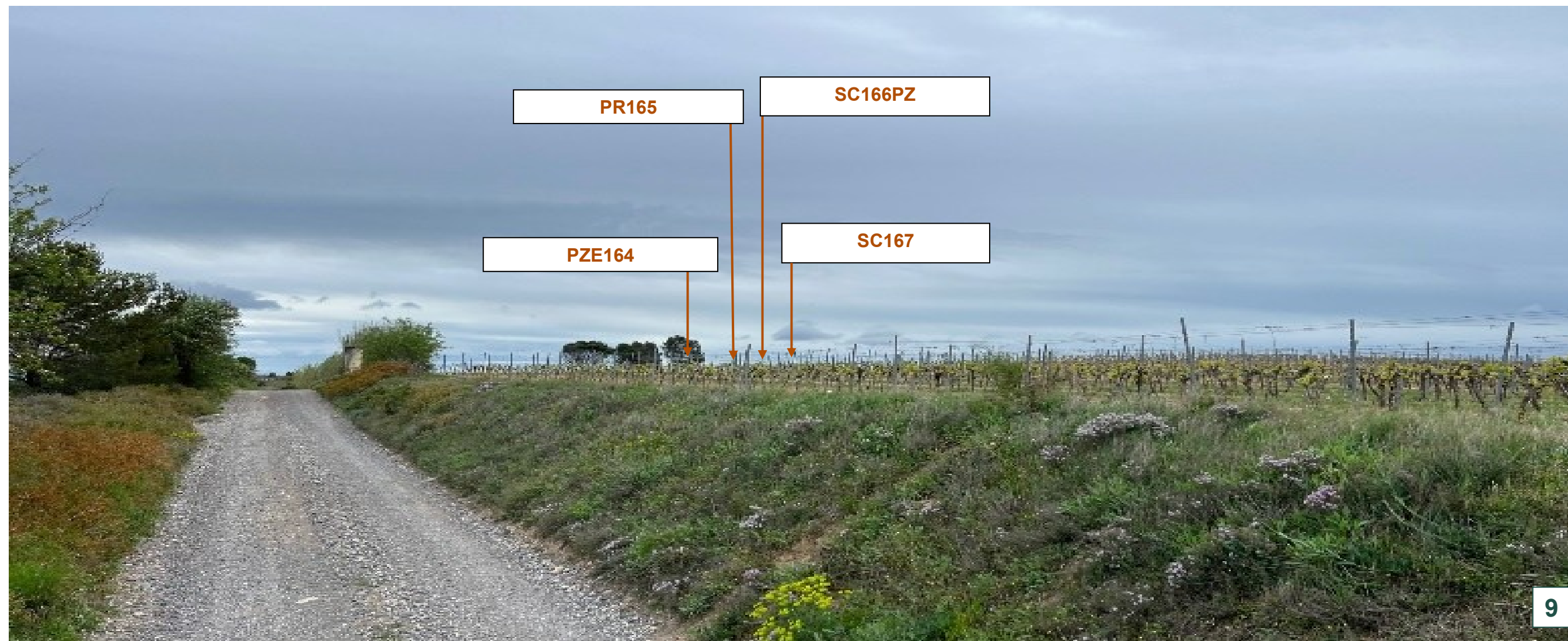
Photo 12 : Panorama global des interventions préparatoires concernées depuis l'extrémité Ouest du tronçon de la Via Domitia
