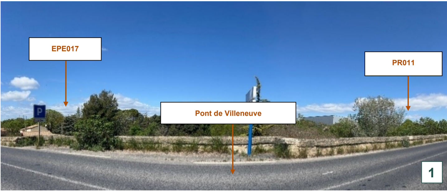
Photo 3 : Panorama global des sondages concernés depuis la RD 612 sur le pont de Villeneuve (Source : Egis, 2024)
