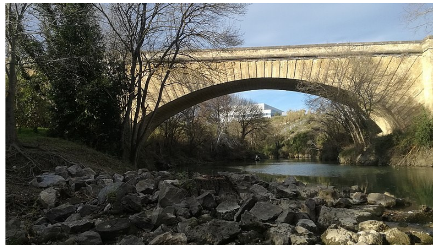
Photo 2 : Pont sur la Mosson (Source : Monumentum)
