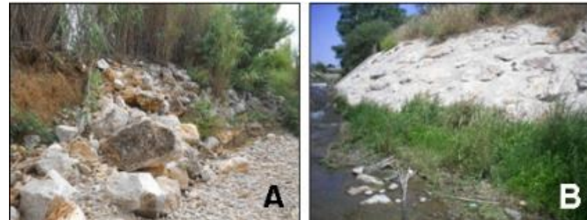
Photo 9 : Exemples de protection de berges (Source : ASCONIT Consultants)
