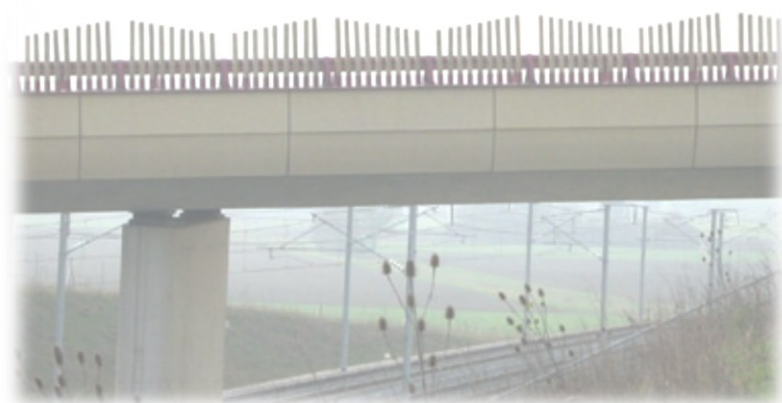
Photo 41 : Aménagements pour les chiroptères (LGV Est européenne) (Source : SNCF Réseau)
