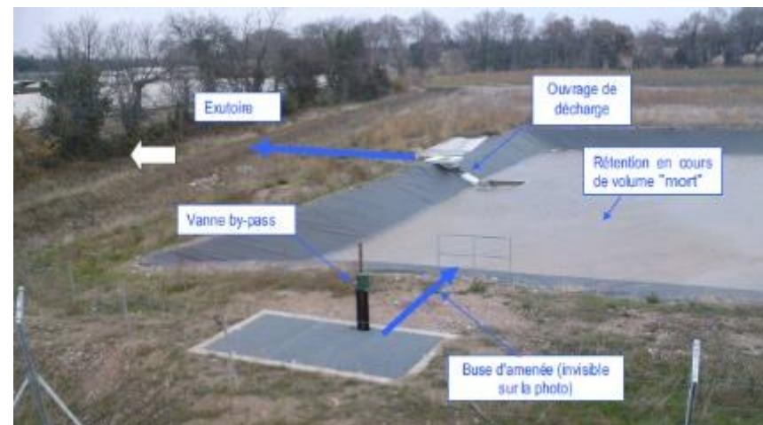
Photo 1 : Exemple de bassin multifonctions (BMS)
