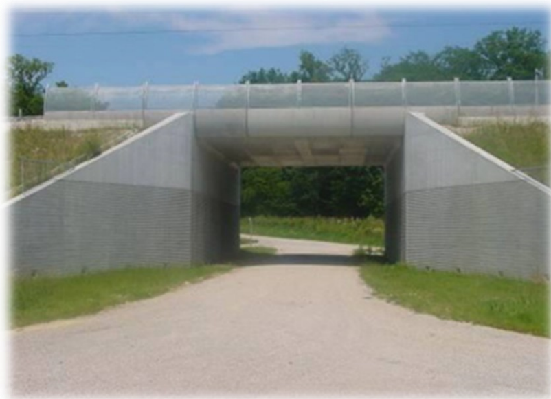
Photo 45 : Pont cadre à usage mixte – Faune / Voies d'accès (Sources : ECOMED (haut), SNCF Réseau (bas))
