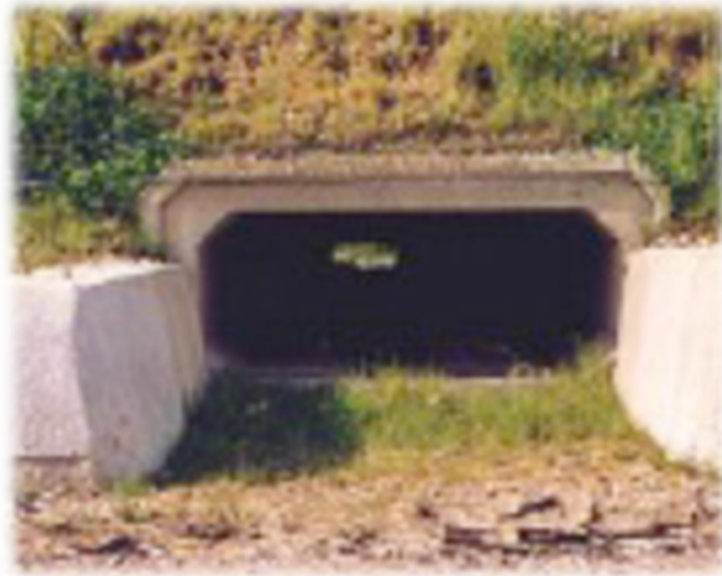
Photo 42 : Exemple de dalots adaptés au passage des amphibiens (Source : Jean Carsignol, 09/05/2011)
