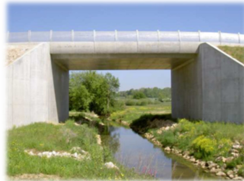
Photo 43 : Ouvrage de type « portique » préservant berges et lit mineur (LGV Rhin-Rhône) (Source : SNCF Réseau)
