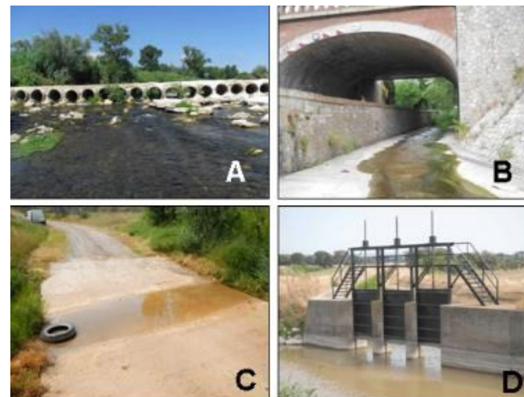
Photo 10 : Exemples d'ouvrages en lit mineur (Source : ASCONIT Consultants)
