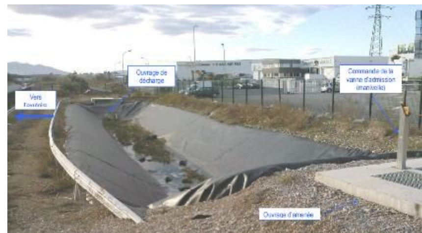
Photo 2 : Exemple de bassin de confinement (BC)
