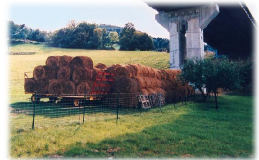
Photo 40 : Viaduc (Source : Jean Carsignol, 09/05/2011)
