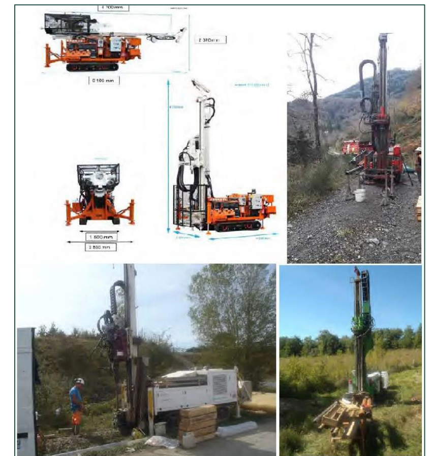
Figure 2 : Exemple de machine utilisée pour les sondages carottés, à la tarière ou pressiométrique (source SNCF Réseau)
