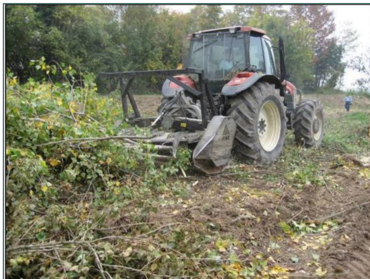
Figure 3 : Procédure de débroussaillage (source SNCF Réseau)
